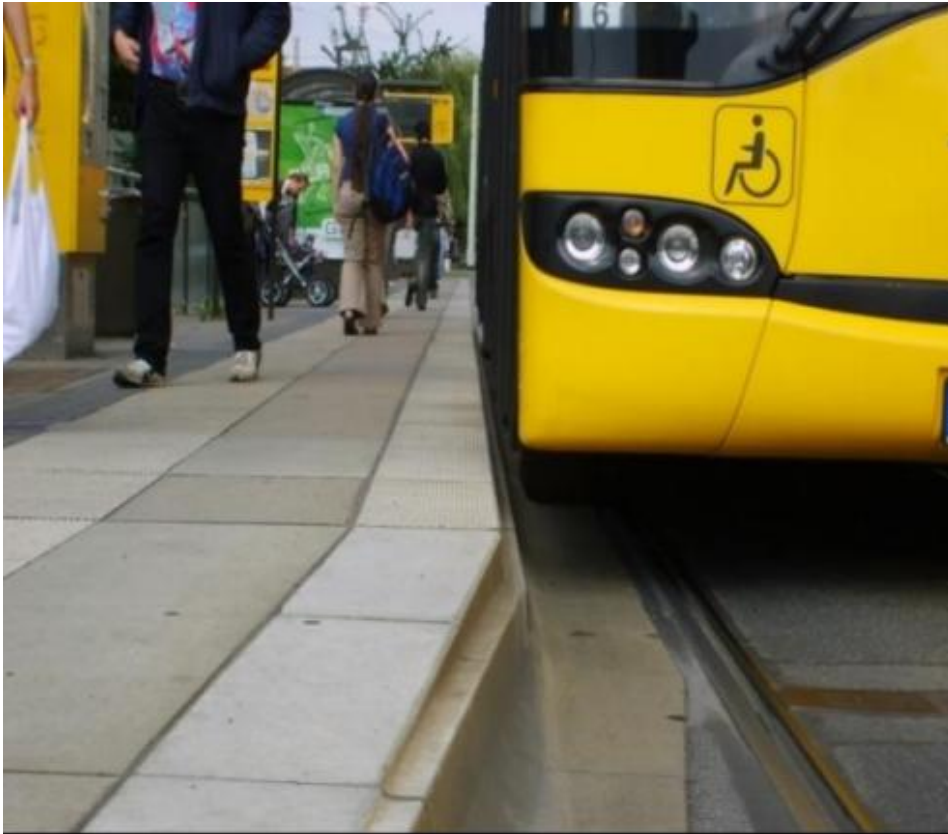
Rys. 9.2 Zalecane ukształtowanie podniesionej krawędzi peronowej – wyrównanie z pierwszymi stopniem w autobusie
