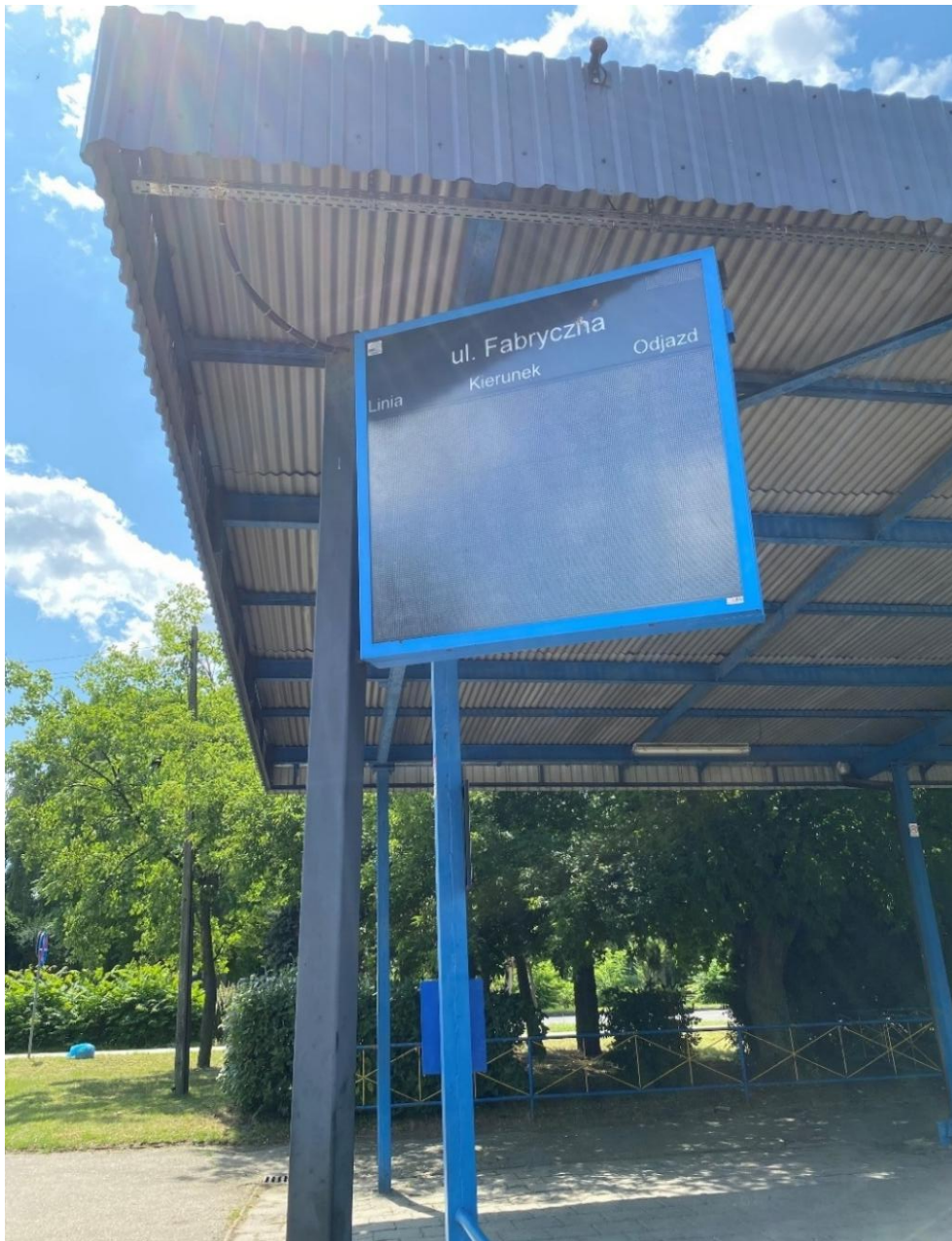
Rys. 11.2 Tablica z dynamicznym systemem informacji pasażerskiej na Dworcu Autobusowym w Krotoszynie
